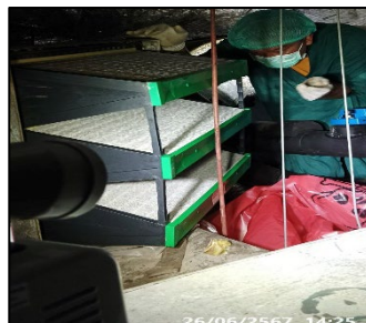
ภาพที่ ค-4 ทำความสะอาดเครื่องปรับอากาศและทำการเปลี่ยน HEPA Filter ระหว่างเดือนมกราคม - มิถุนายน 2567
