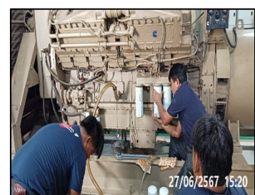
ภาพที่ ค-3 การตรวจสอบและบำรุงรักษาระบบไฟฟ้าสำรองฉุกเฉิน ระหว่างเดือนมกราคม - มิถุนายน 2567
