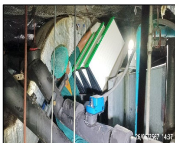
ภาพที่ ค-4 ทำความสะอาดเครื่องปรับอากาศและทำการเปลี่ยน HEPA Filter ระหว่างเดือนมกราคม - มิถุนายน 2567
