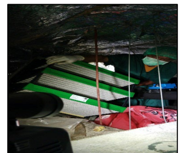
ภาพที่ ค-4 ทำความสะอาดเครื่องปรับอากาศและทำการเปลี่ยน HEPA Filter ระหว่างเดือนมกราคม - มิถุนายน 2567
